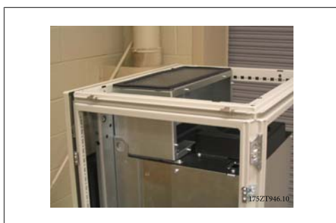
Bild 3.46: Övre kanal installerad
