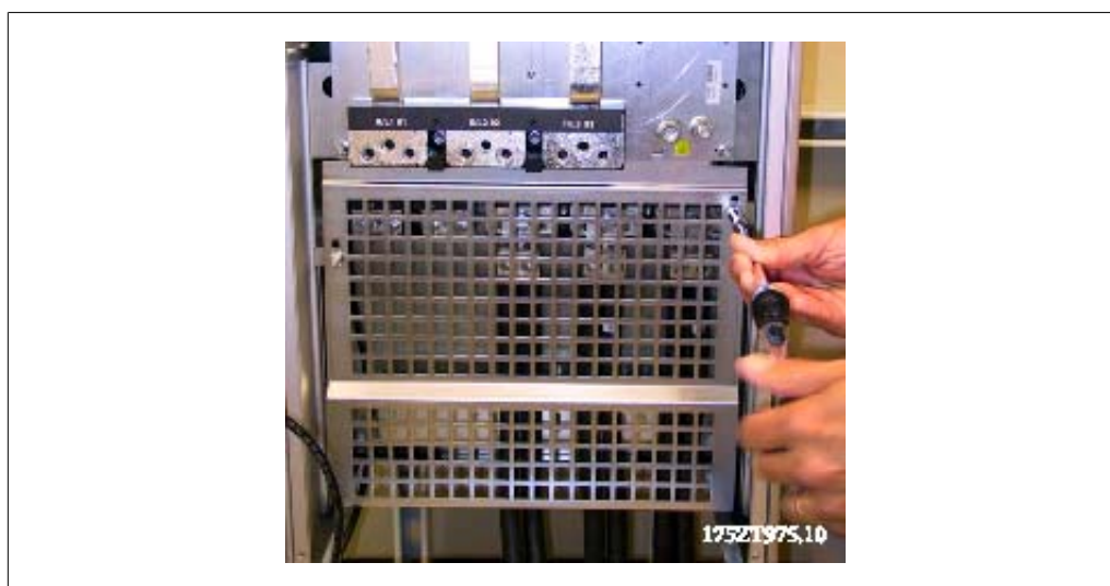
Bild 3.81: Montering av EMC-skärm
