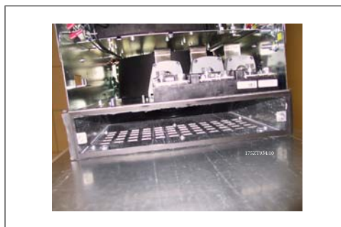
Bild 3.33: Nedre kanaladapter monterad
