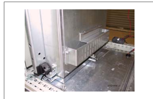
Bild 3.59: Nedre kanal monterad.
