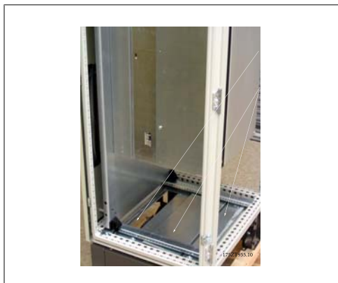
Bild 3.55: Nedre utskärning för kapsling
