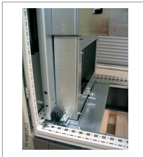
Bild 3.54: Montera tillfälligt kanalen för att märka ut utskärningen på boxen
