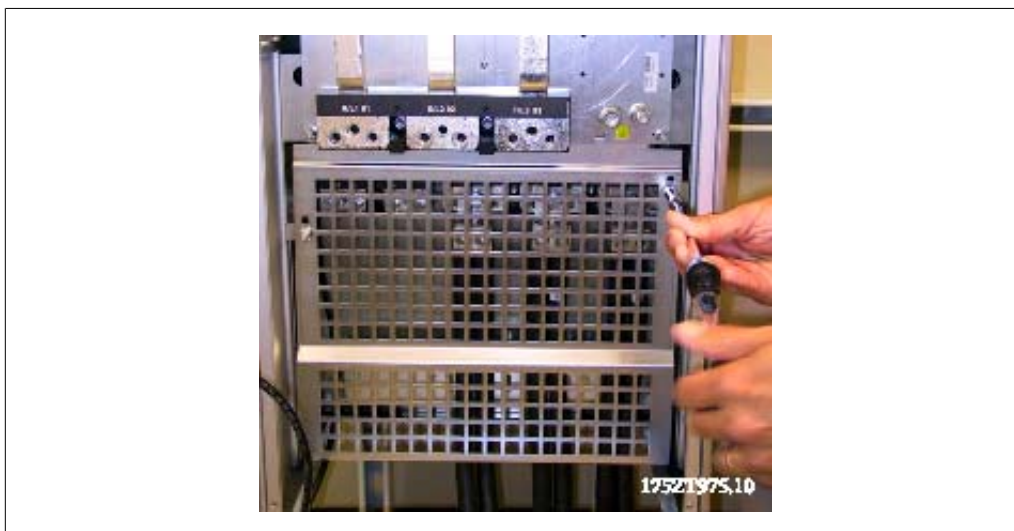
Kuva 3.81: EMC-standardin mukaisen suojuksen asentaminen.
