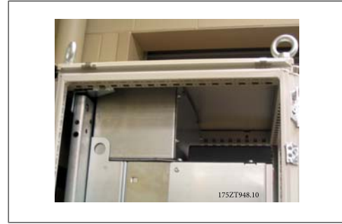
Kuva 3.49: Kotelon yläosa asennettuna
