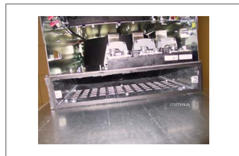
Kuva 3.33: Pohjaputken sovitin asennettuna
