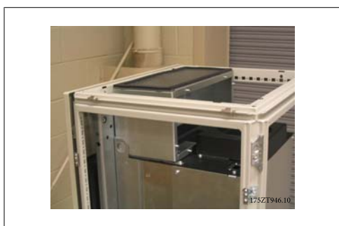
Kuva 3.46: Putkiston yläosa asennettu
