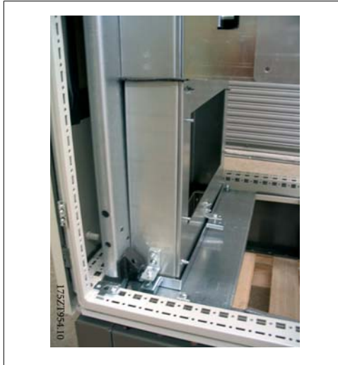
Kuva 3.54: Asenna putkisto tilapäisesti merkitäksesi pois leikattavan kohdan läpivientiin
