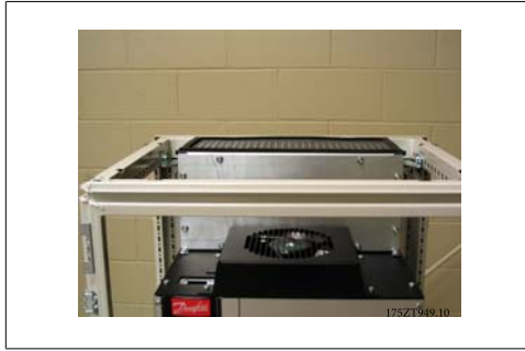
Kuva 3.48: Yläputken sulkulevy asennettuna
