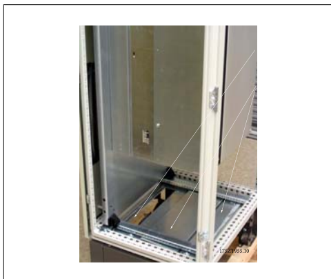
Ilustração 3.55: Corte da parte inferior do gabinete metálico
