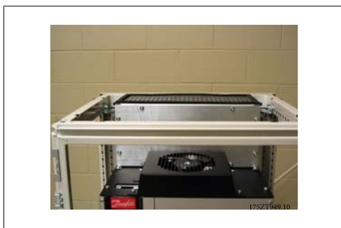
Ilustração 3.48: Chapa de fechamento do duto superior instalada
