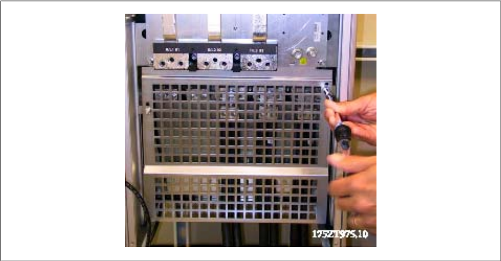
Ilustração 3.81: Montagem da proteção de EMC
