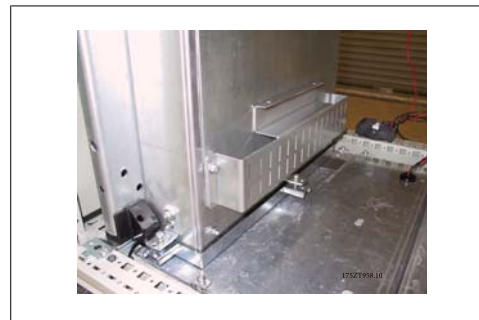
Ilustração 3.59: Duto inferior instalado.
