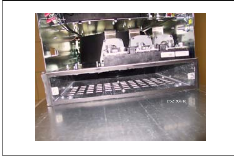
Ilustração 3.33: Adaptador do duto inferior instalado
