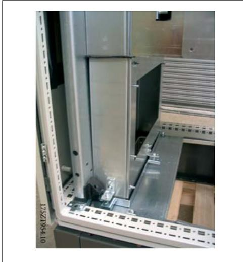
切口是在最內面纜線固定頭板上切出的。必須移除剩餘的兩個纜線固定頭板，以安裝底部導管組件。
