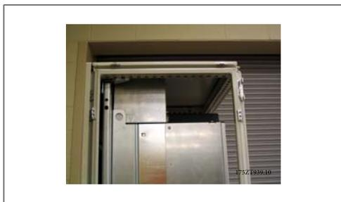
圖 3.38: 已安裝的上方管路工件與外殼頂部
