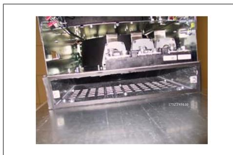
圖 3.33: 已安裝的底部導管配合件
