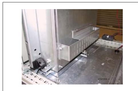
圖 3.59: 已安裝的底部導管。
