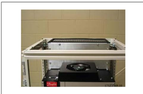
圖 3.48: 安裝完成的上方導管關閉板
