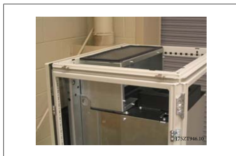
Ilustracja 3.46: Zainstalowany górny kanał
