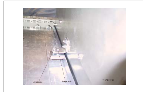
Ilustracja 3.58: Przenieść śruby z zewnętrznego do wewnętrznego otworu.
