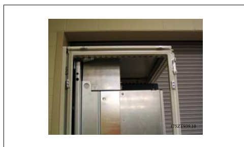
Ilustracja 3.38: Zainstalowany górny kanał oraz górna część obudowy
