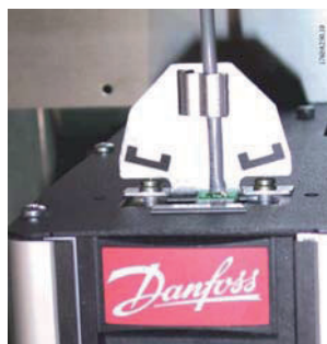
Abbildung 6.36: Anschluss von oben für Feldbus
