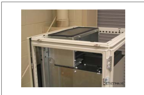
Abbildung 3.46: Montierte obere Lüftungsbaugruppe
