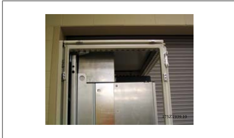
Abbildung 3.38: Montierte obere Lüftung und Schaltschrank-Dachblech
