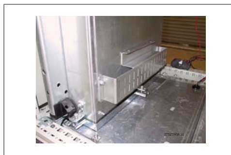
Disegno 3.59: Condotto inferiore installato.
