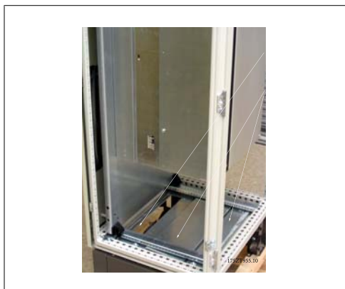
Disegno 3.55: Apertura inferiore della custodia
