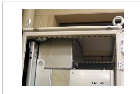
Kuva 3.49: Kotelon yläosa asennettuna
