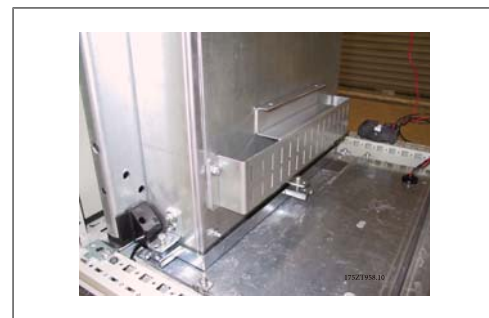
Kuva 3.59: Pohjaputki asennettuna.
