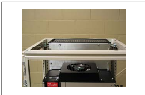
Kuva 3.48: Yläputken sulkulevy asennettuna
