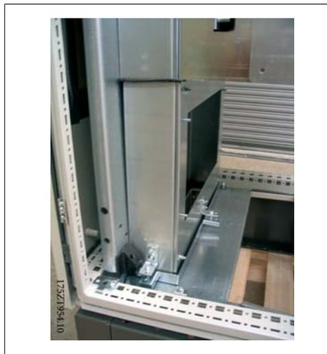
Ilustração 3.54: Instale temporariamente a tubulação para marcar o corte na bucha.
