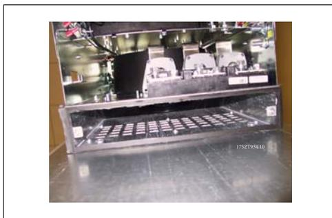
Ilustração 3.33: Adaptador do duto inferior instalado
