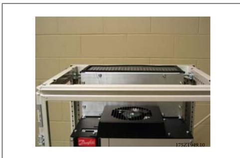
Ilustração 3.48: Chapa de fechamento do duto superior instalada
