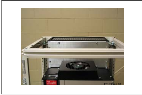
圖 3.48: 安裝完成的上方導管關閉板
