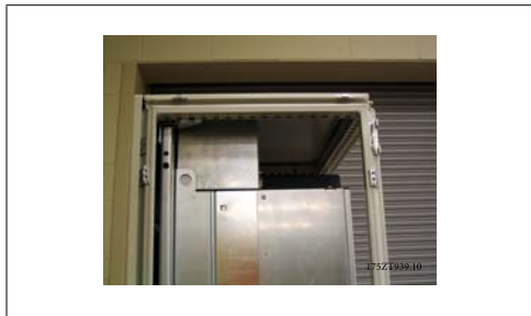
圖 3.38: 已安裝的上方管路工件與外殼頂部
