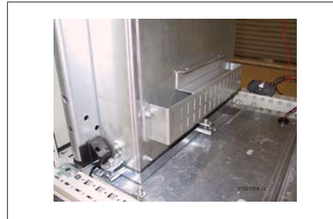
圖 3.59：已安裝的底部導管。
