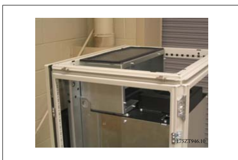
圖 3.46: 安裝完成的上方導管
