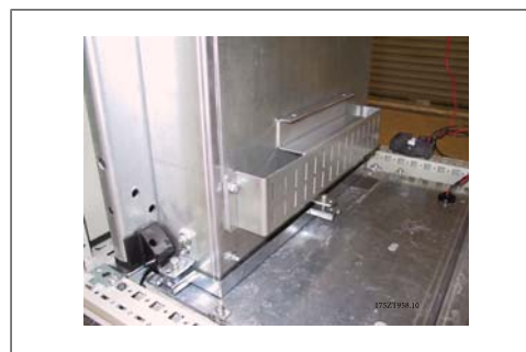
Ilustracja 3.59: Zamontowany dolny kanał kablowy.
