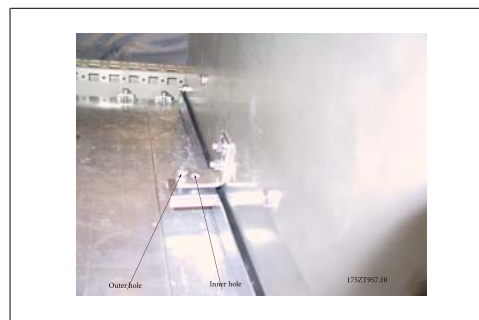
Ilustracja 3.58: Przenieść śruby z zewnętrznego do wewnętrznego otworu.
