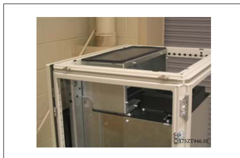
Ilustracja 3.46: Zainstalowany górny kanał
