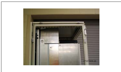
Ilustracja 3.38: Zainstalowany górny kanał oraz górna część obudowy
