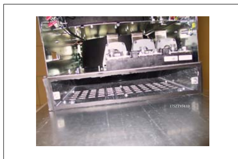
Рисунок 3.33: Установленный переходник нижнего воздуховода
