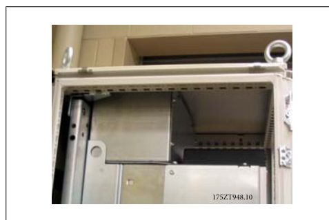
Рисунок 3.49: Установленный верх корпуса
