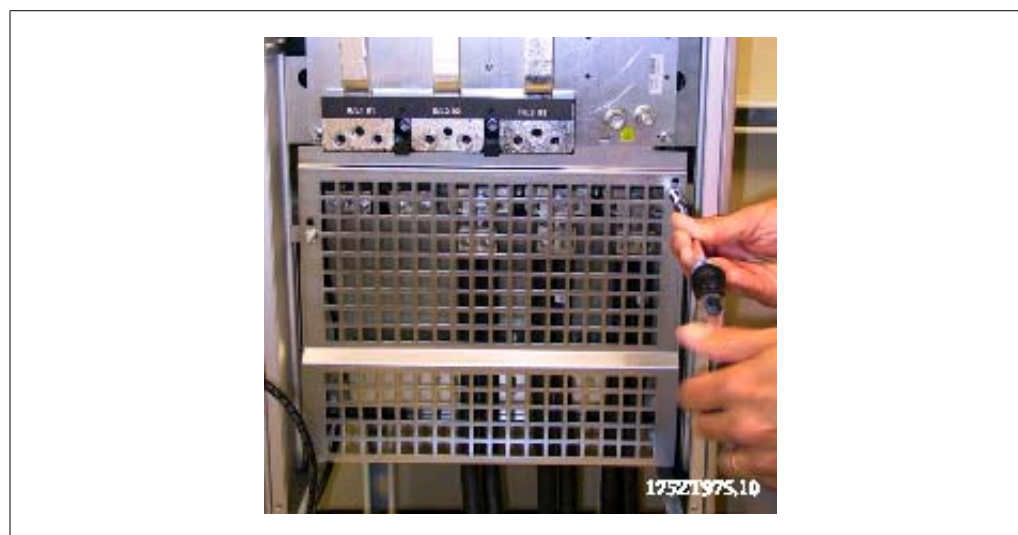
Рисунок 3.81: Монтаж экрана ЭМС
