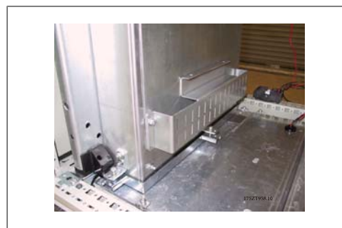
Рисунок 3.59: Установленный нижний воздуховод.
