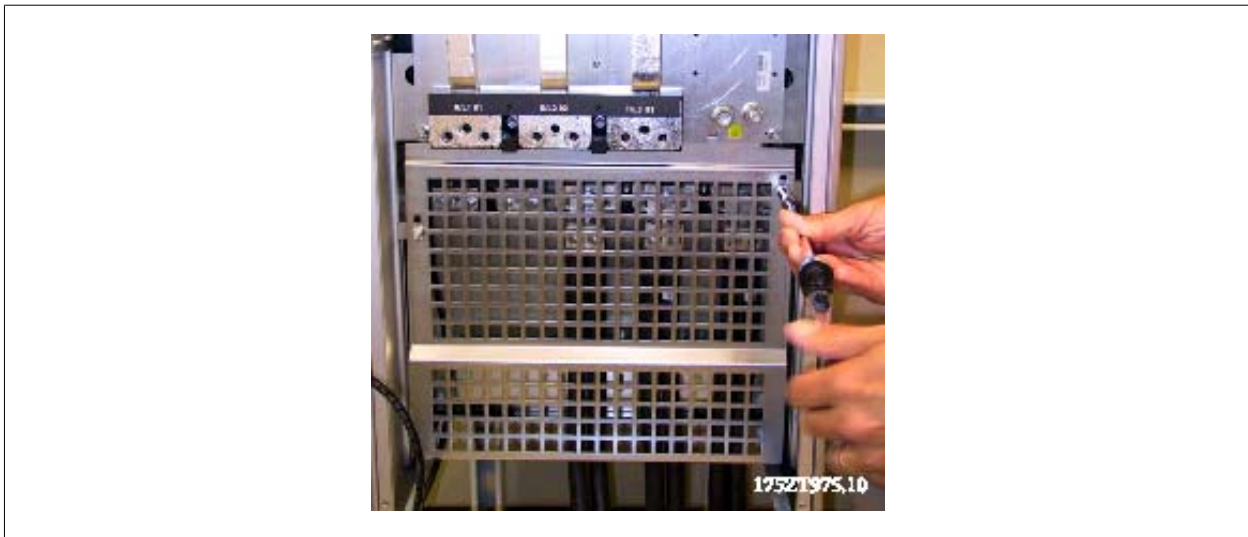
圖 3.47: EMC 防護裝置的安裝。
