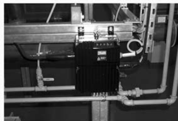
Disegno 1.15: Nuova soluzione: controllo motore decentralizzato originale
