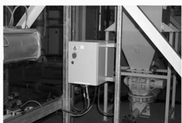
Disegno 1.14: Vecchia soluzione: Controllo motore - pannello montato decentralizzato
