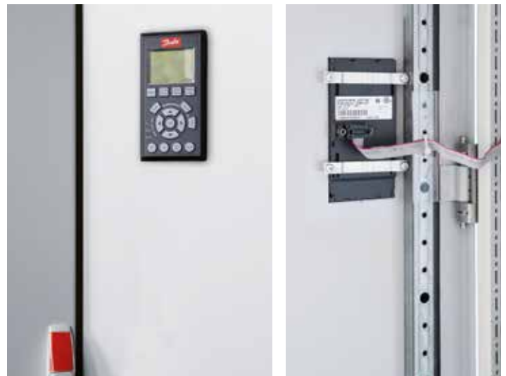
Frequenzumrichter lassen sich auch bei geschlossener Schaltschranktür parametrieren und auslesen.
