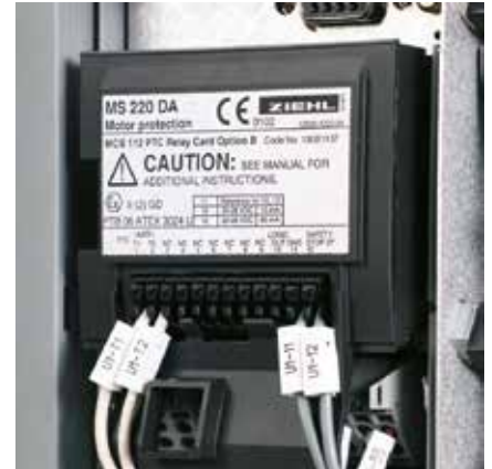
Die PTC Thermistor Card MCB112 kann, wie jede andere Option des VLT® AutomationDrive FC 302 auch, vor Ort schnell und kostengünstig per „Plug & Play“ nachgerüstet werden.
