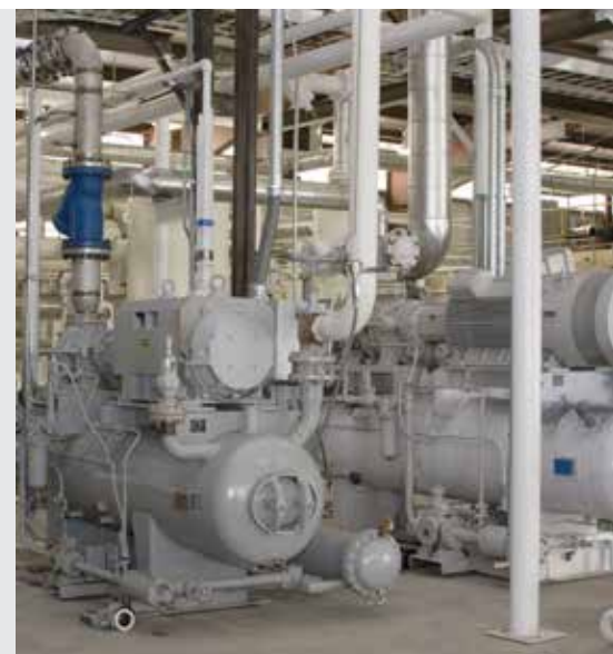
De snelheidsregeling van de hoofdcompressor plus een extra compressor zorgt voor verbeterde en gestroomlijnde ontwerp-mogelijkheden en een betere keuze van het compressorformaat voor uiteenlopende 60Hz-belastingomstandigheden
