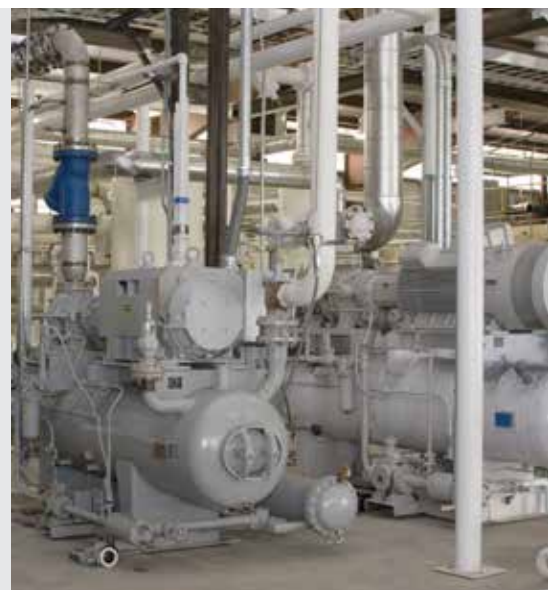
Sterowanie prędkością sprężarki głównej i jednej dodatkowej zapewnia lepsze i prostsze możliwości projektowe oraz lepszy wybór wielkości sprężarek pasujących do zmiennych warunków obciążenia.
