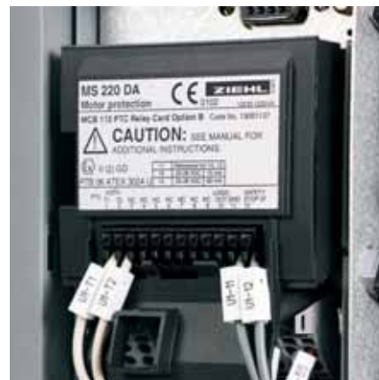
Stejně jako všechny ostatní volitelné doplňky měniče VLT® Automation Drive FC 302 lze kartu s PTC termistorem MCB112 rychle a snadno vyměnit na místě během provozu.
