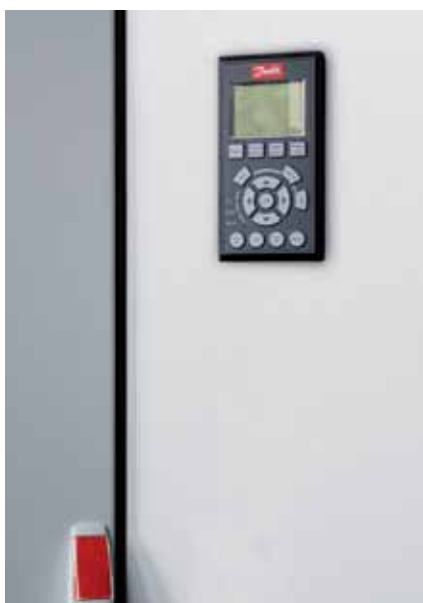
Nastavování a odečítání parametrů frekvenčního měniče lze provádět i při uzavřených dveřích rozváděče.
