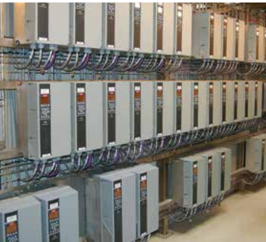
Tipična instalacija na koju je priključen veliki broj frekventnih pretvarača često zahteva dodatno filtriranje harmonika kako bi se izbeglo izobličenje napona mreže.
