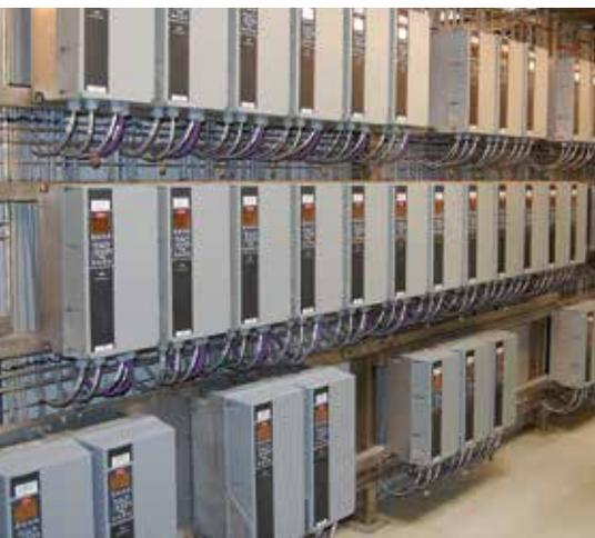
*При установке приводов с многочисленными преобразователями частоты с питанием от одного источника тока требуется дополнительное подавление гармоник для того, чтобы избежать гармонического искажения напряжения.*
