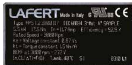
I parametri dell'inverter sono inseriti a seconda delle informazioni presenti nella targhetta del motore, e nelle specifiche del documento tecnico del motore.
