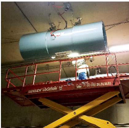
Werk in uitvoering aan een ventilatie-eenheid.
