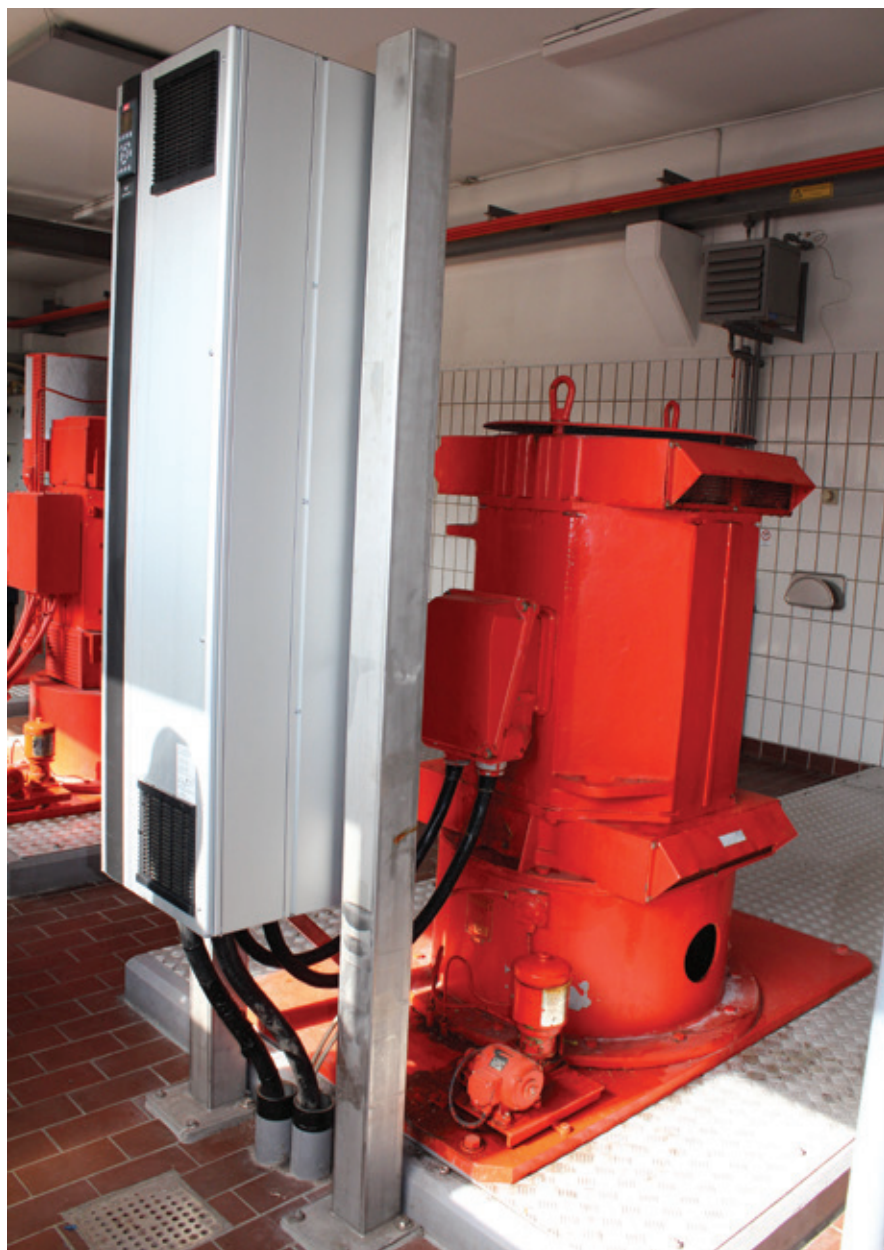
Udledningspumpe: en VLT® frekvensomformer på 160 kW med IP 54 kapsling kontrollerer denne 1,25 tons tunge pumpe.
