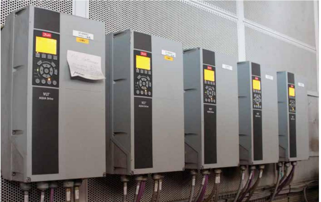
生物气体发电：VLT® AQUA 变频器控制冷却风扇，提高工厂效率。
