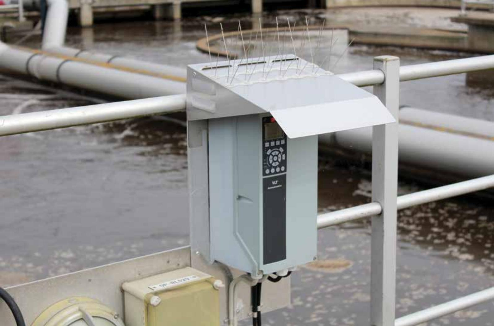
活性污泥硝化和反硝化：带有 PROFIBUS、RFI 滤波、IP 66 等级机箱和气候防护罩的 16 台 4 kW VLT® 变频器控制着好氧混合器。
