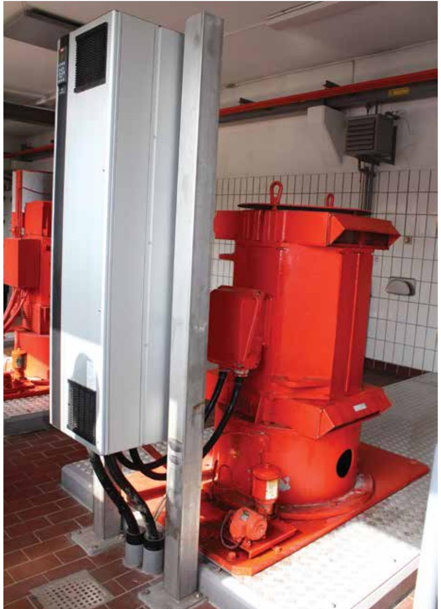
排水泵站：具有 IP 54 箱体的 160KW VLT® 控制着重量为 1.25 吨的泵
