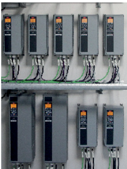
MEC – BioGas har anvendt tæthedsklasse IP55 på en del af deres VLT® AutomationDrive FC 302, da denne type er særligt velegnet til installation i krævende miljøer.
