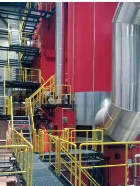
Vertikal biobrændselskedel og rensning af røggas
