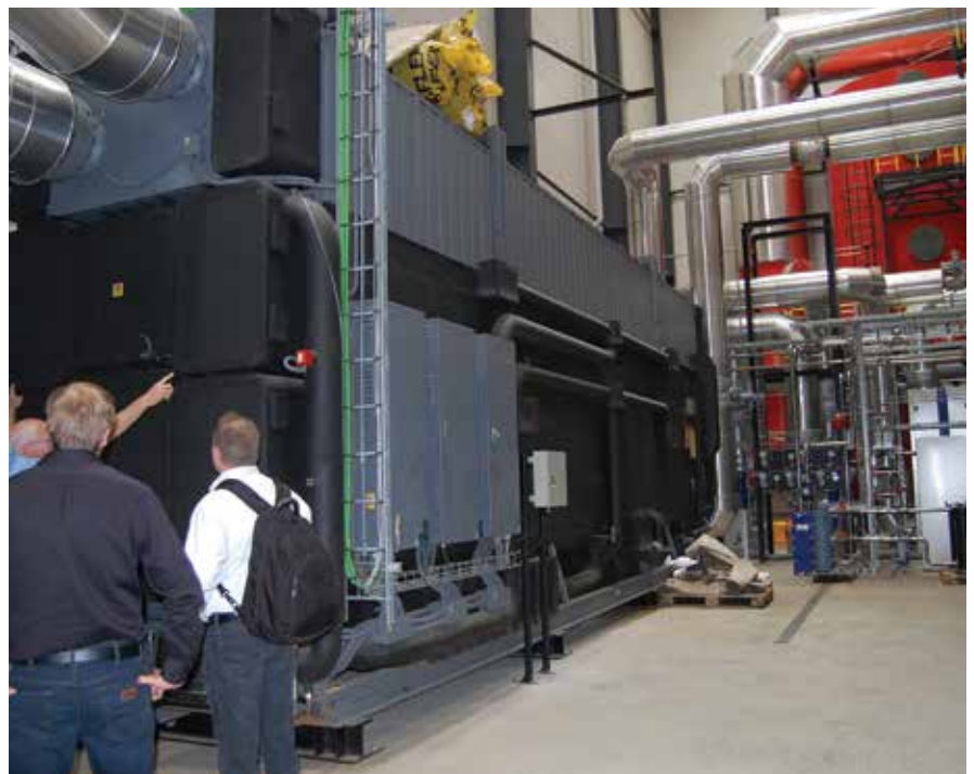
I forgrunden en absorber. I baggrunden skrubberne.
