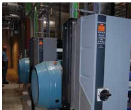
Moteurs SynRM IE4 équipés de variateurs de fréquence VLT® AutomationDrive FC302.
