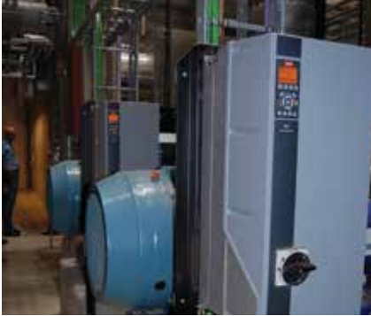
VLT® Automation Drive FC302 frekans konvertörleri ile donatılmış IE4 SynRM motorlar.
