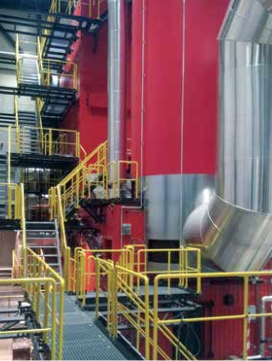
Dikey biyoyakıt kazanı ve baca gazı basınçlı havayla (shotblast) temizleme.
