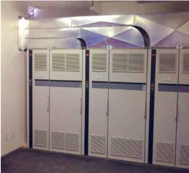
矿场疏干系统中带有背部通道冷却控制电机的这些 VLT® Automation Drive 变频器。这些变频器安装在 MCC 变电站中。
