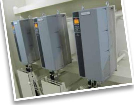
“使用丹佛斯 VLT® 变频器后，泵始终以最佳冷却水平运行，以节省能源。同样的原理也适用于在空调系统中使用这些变频器时，”
