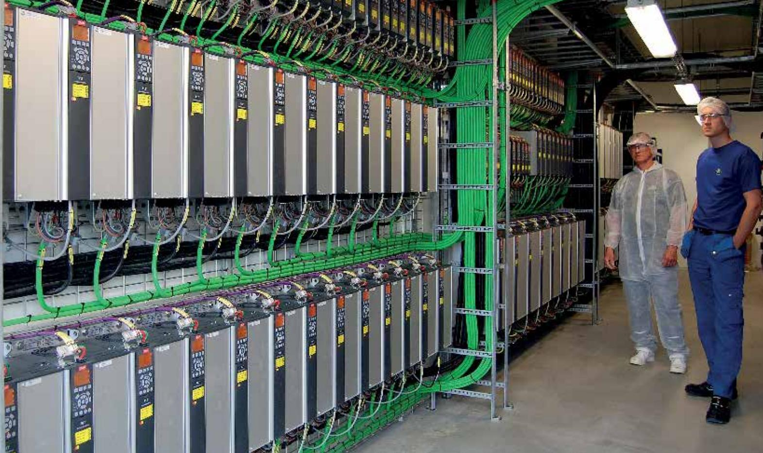
1400个VLT®变频器安装在一系列通风良好的控制室内，无需控制柜。
