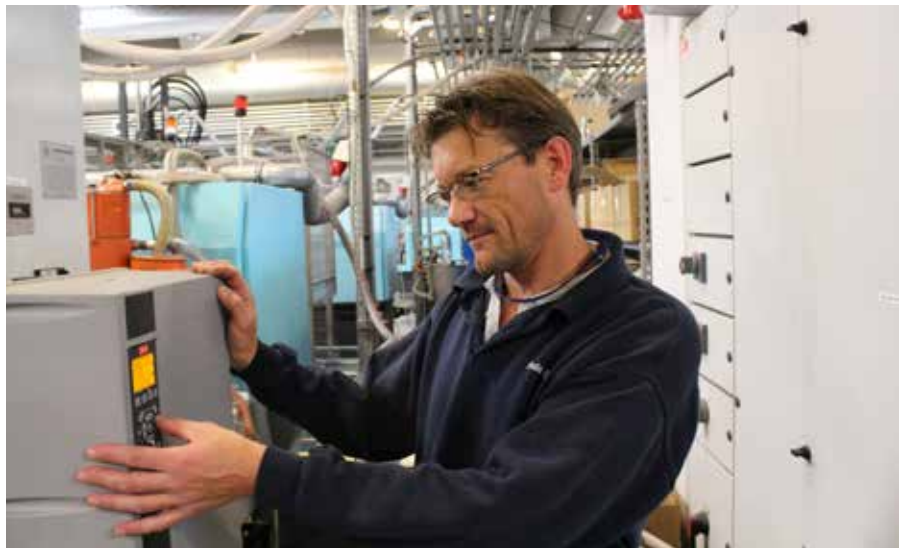
PTA-teamleder Freddy Søby ved en af de 55 kW frekvensomformere, der styrer sprøjtestøbemaskinerne.
