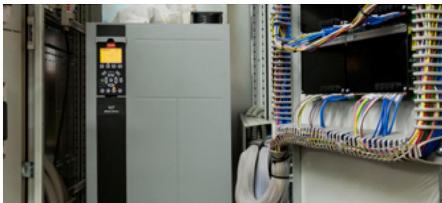
Danfoss Drives VLT® HVAC Drive FC102 250 kW montato all'interno del suo cubicolo
