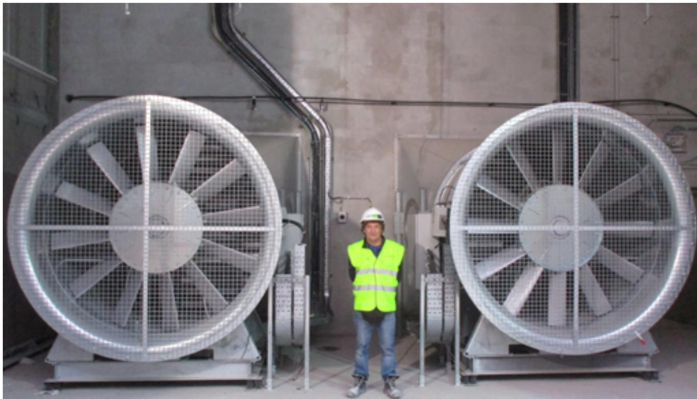
N.2 ventilatori assiali reversibili modello AXR 2000-12, certificati per funzionamento in caso d'incendio a 250°C per 2 ore, e dotati di motori elettrici trifase da 250kW.
