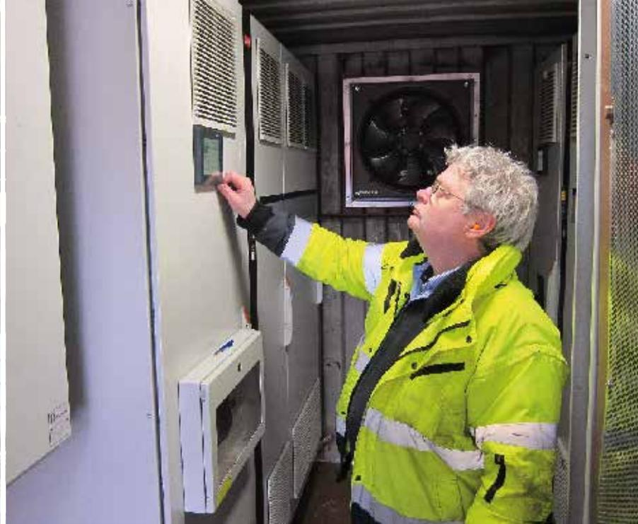
VLT®变频器采用背部通道冷却系统进行冷却，该系统通过机箱壁通风口直接吸入和排出冷却空气。
