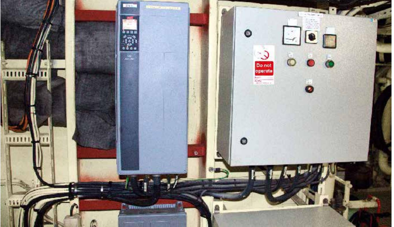
船上的海水冷却泵和引擎室通风系统均由丹佛斯变频器驱动。
