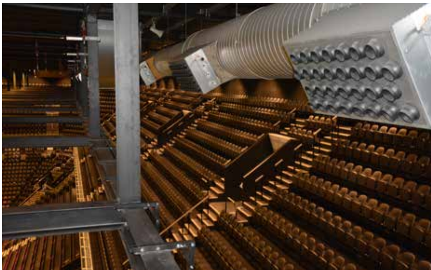
Luchtverversing boven de tribunes aangedreven met Danfoss VACON frequentieomvormers
