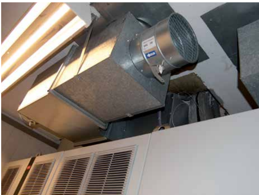
VLT® frekvensomformernes back channel cooling system er tilsluttet direkte til kontrolrummets ventilationsanlæg
