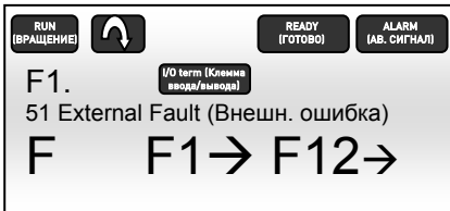
Рис. 7.1-5. Аварийный сигнал наличия протечки на панели NXP
