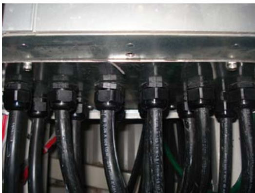
Illustration 3.14: Eksempel på korrekt installation af tætningspladen.
