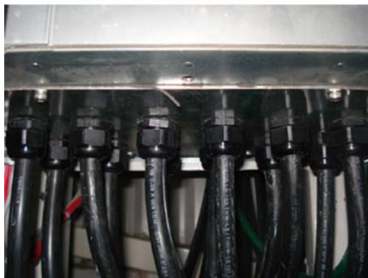
Рисунок 3.14: Пример правильной установки платы уплотнений.
