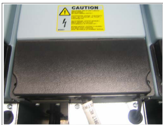
图 13. 单元中的光缆终端（例如 F113）
