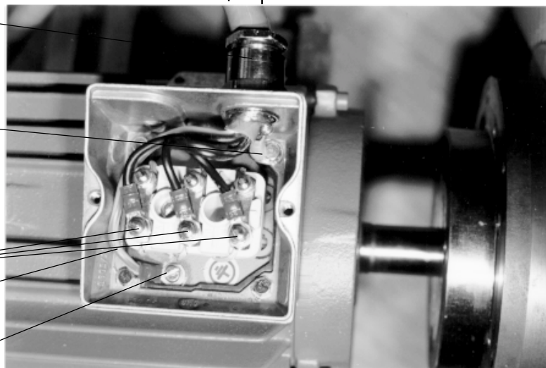
Figur 6.1.4-15 Kabelmontering i frekvensomvandlaren och i motorn typer 2.2—45 CXL4/CXL5 (EMC nivå I och C).
