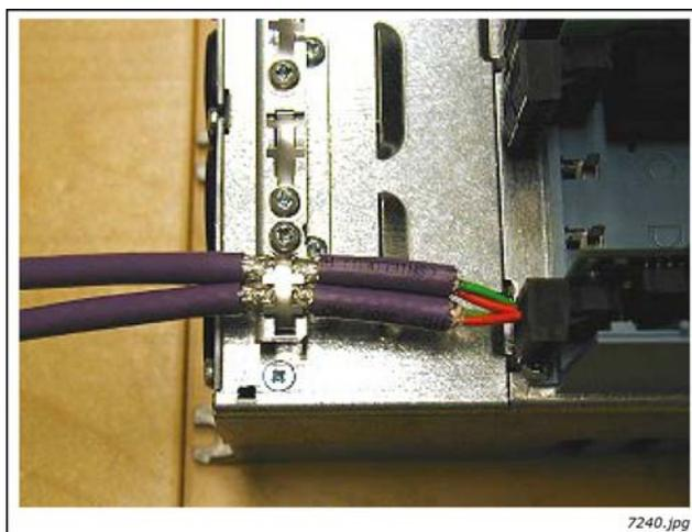
Figura 10. Puesta a tierra del cable de control
