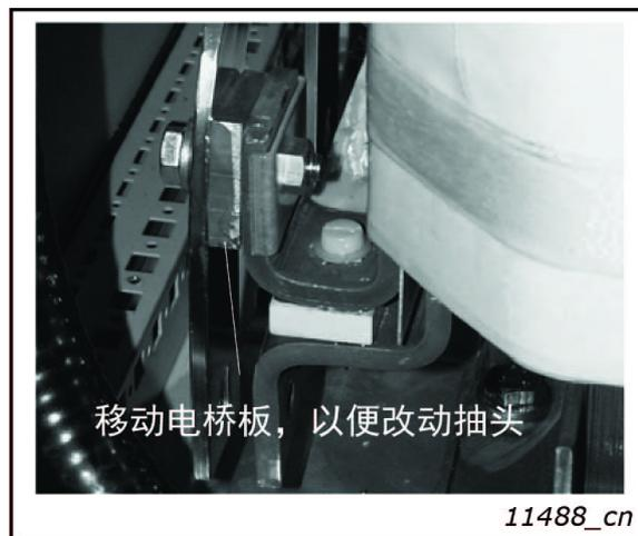
图 7. FR13/14 装置中的输入电抗器抽头
