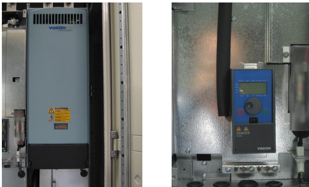
Рис. 5–4. Установка блока управления
