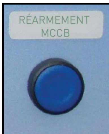
Figure 30. Bouton de réarmement MCCB (-S11)
