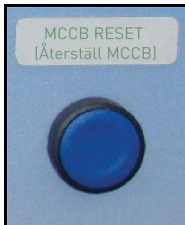
Figur 30. Tryckknappen MCCB Reset (-S11)
