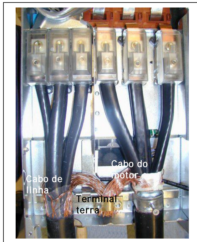
Figura 6-17. Instalação dos cabos no Vacon NXS/P, FR8
