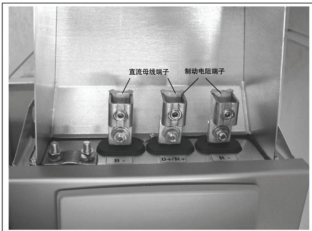
图 6-19. FR8 变频器顶端的制动电阻接线盒
