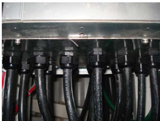
Kuva 5.14: Esimerkki läpivientilevyn asianmukaisesta asentamisesta.
